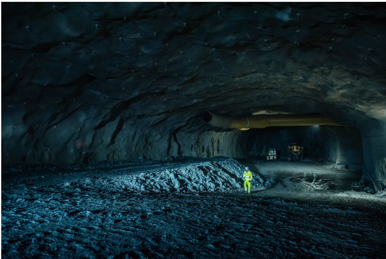
Fornebuporten stasjonshall under arbeid. Foto: Fornebubanen / Nicolas Tourenc
